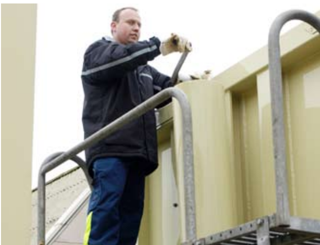
Et godt eksempel på skridsikker belægning og fastmonteret trin.
